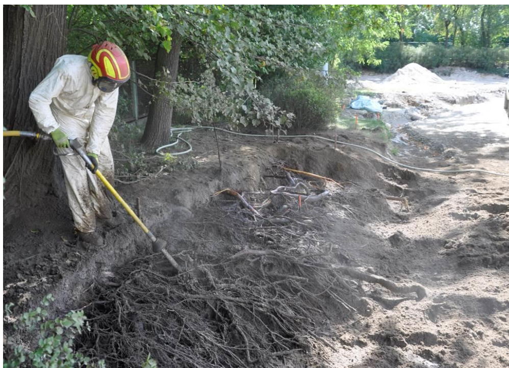
Ryc. 13. Odkrywanie systemu korzeniowego drzew za pomocą sprężonego powietrza. Fot. Maciej Motas (Arborysta.com)
