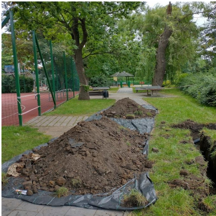
Ryc. 12. Przykład zabezpieczenia nawierzchni ciągu pieszego w czasie prowadzenia wykopu. (fot. Ł. Dworniczak)
