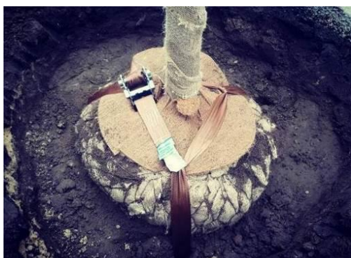
Ryc. 36. Stabilizacja drzewa za pomocą pasów Fot.. Piotr Drozda.
